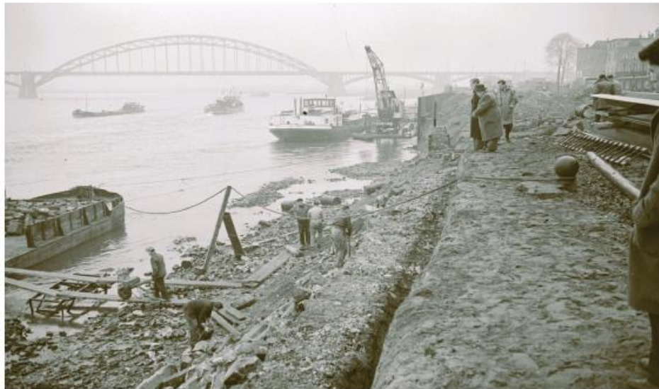
Foto: Herstelwerkzaamheden aan de voet van de kademuur 1955
